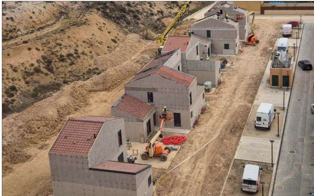
Imagen aérea de las viviendas de Langa de Duero cuando aún estaban trabajando en ellas. HDS
