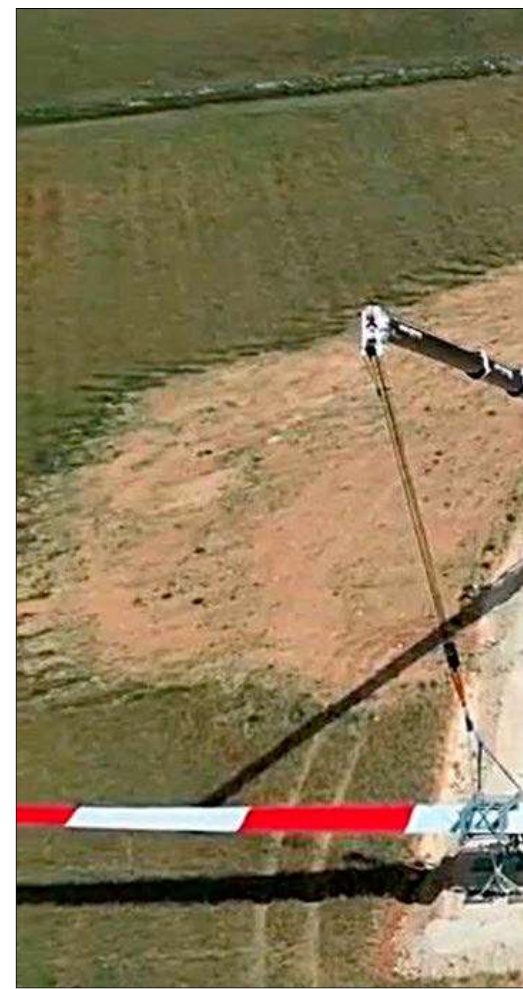
Obras del parque eólico Pinta y Guindalera, del Grupo Vapat, en Villalba de los Alcores (Valladolid), en 2023. GRUPO VAPAT
