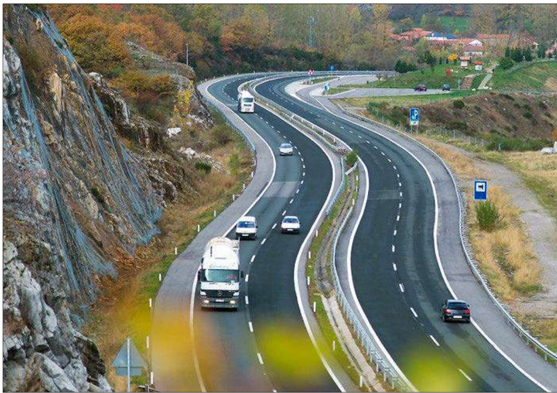
Autopista AP-66 entre León y Asturias. E. M.
